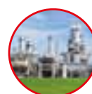
LOCALI AD USO INDUSTRIALE
